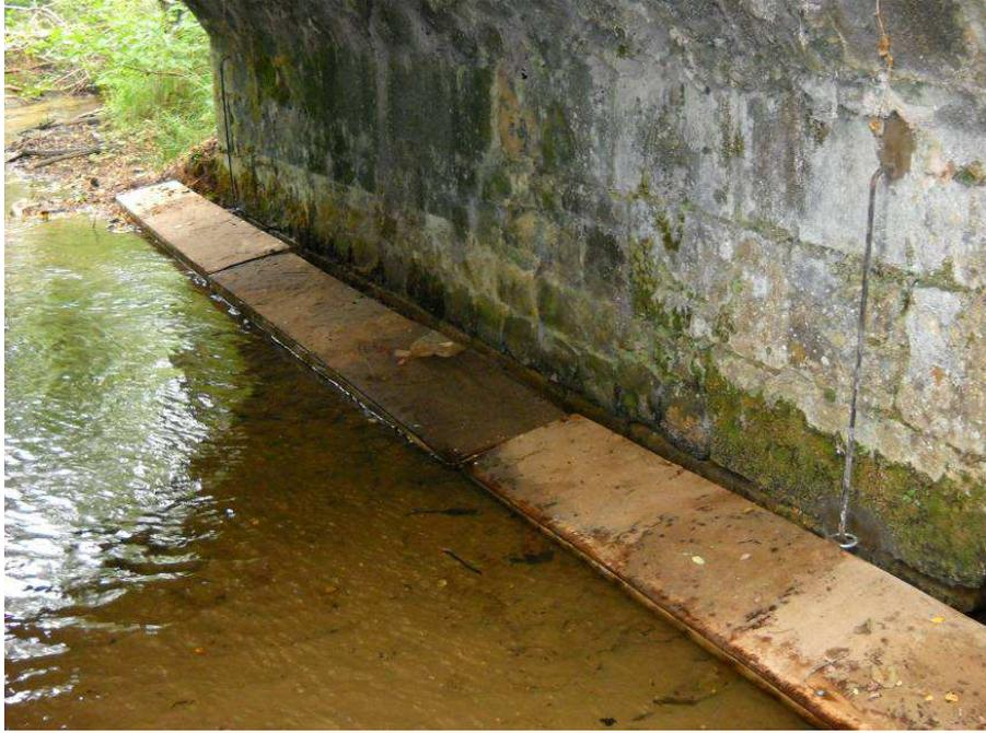
*Ouvrage hydraulique du ruisseau du Ballion équipé d'un ponton GREGE (Photo : Pascal Fournier)*
