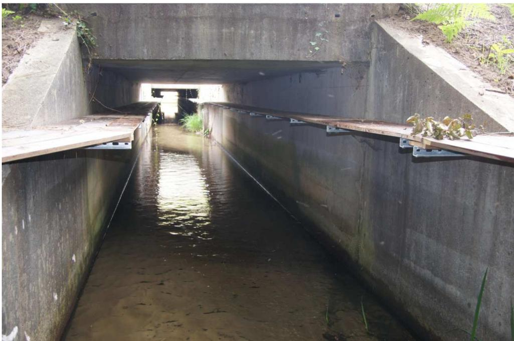
*Encorbellement réalisé par le GIE A63 Constructeurs dans l'ouvrage du ruisseau de Saunus (Photo : Pascal Fournier).*
