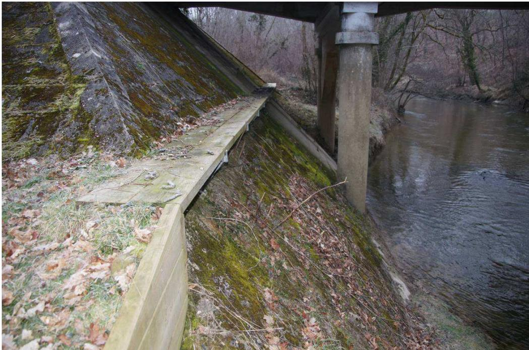
*Encorbellement réalisé par le Conseil général des Landes au pont de Moustey (Photo : Pascal Fournier).*
